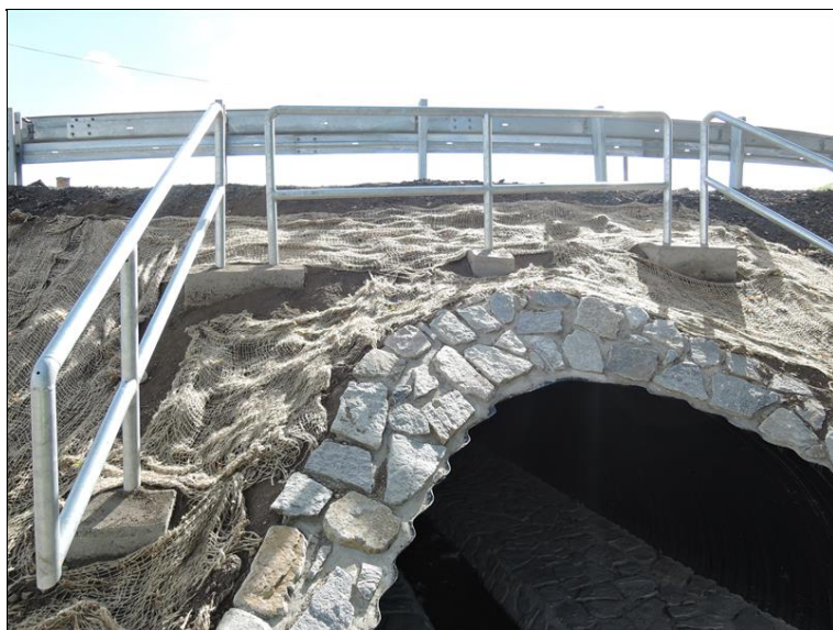
Ztužující límec na vtoku, silniční zábradlí, patky zábradlí vyčnívají nad upravený terén.
