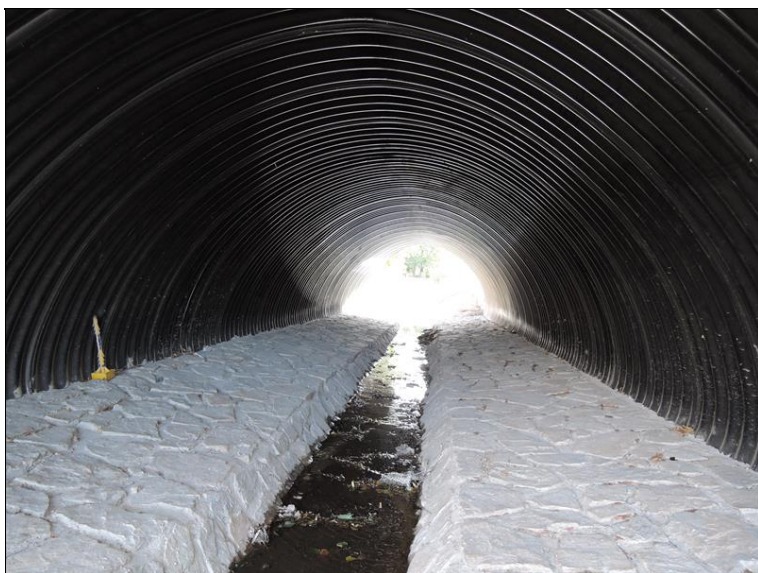
Území pod mostem, zpevněné koryto potoku.
