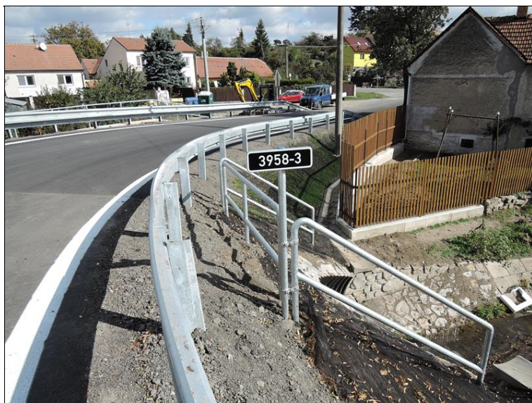
Pravostranné svodidlo, zábradlí a označení mostu.
