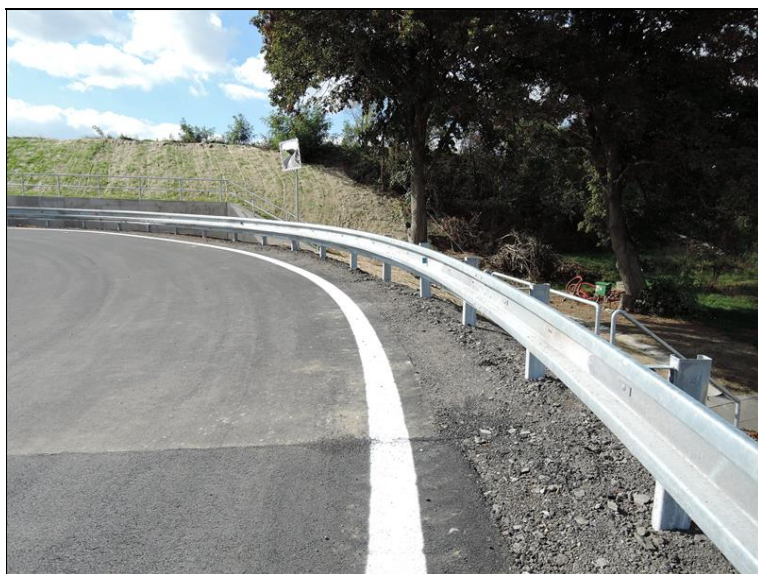
Levostranné silniční svodidlo, nezpevněná krajnice.
