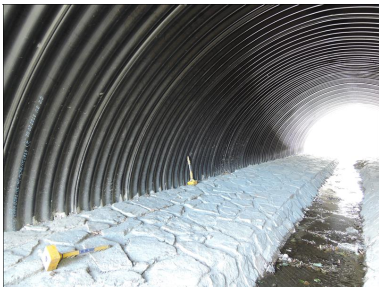
Pohled na opěru 2, zpevnění před opěrou.
