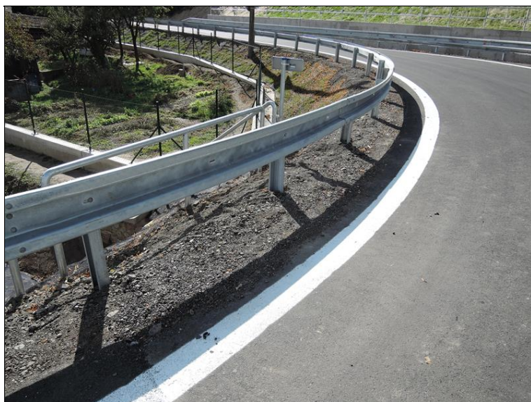
Pravostranné silniční svodidlo, nezpevněná krajnice.
